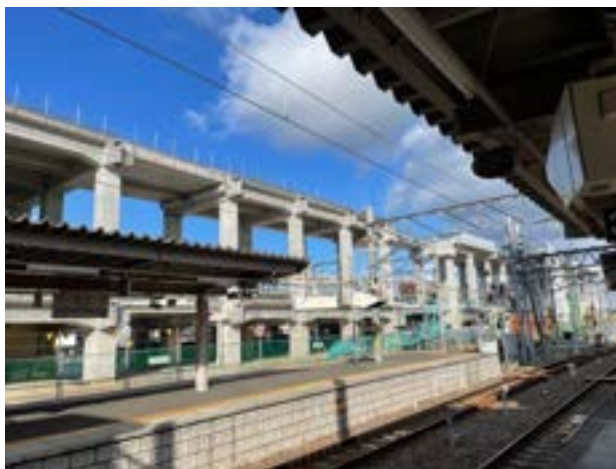
(高架化工事中の知立駅)
